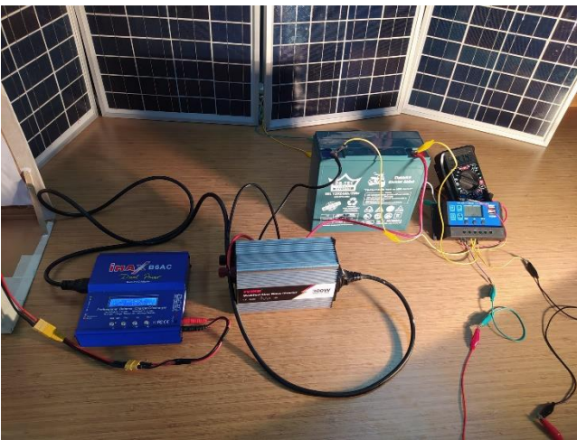
Şekil 23: Akü, inverter ve şarj cihazlarının Bağlantıları
