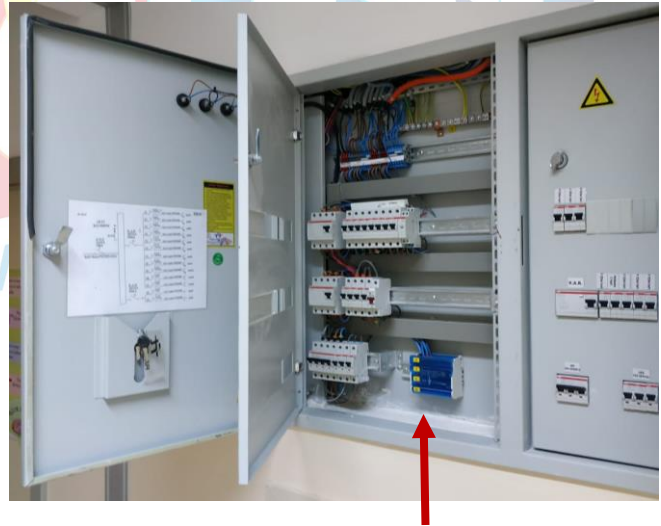
Görsel 2. Elektrik panosuna kontrol rölesi montajı
