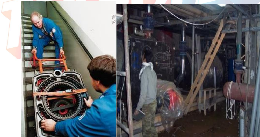
Fotoğraf-2.1: Küçük kapasiteli bir kazanın dilimlerinin taşınması ve bir kazan dairesinin kurulumu.
