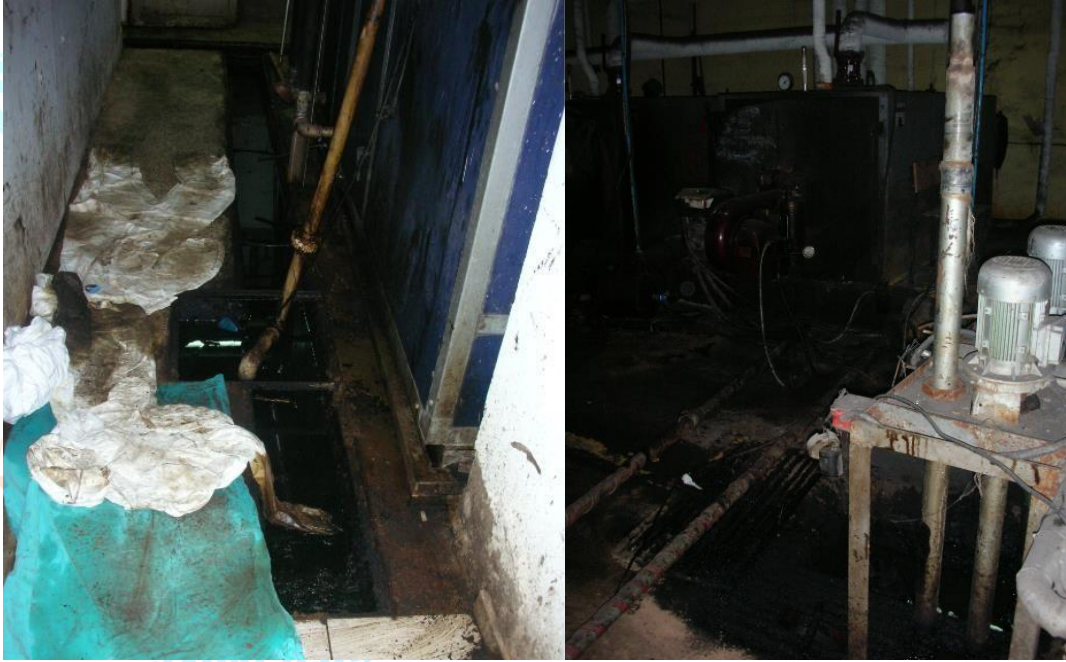
Fotoğraf-2.3: Fuel-oil ile çalışan bir kazanın kazan dairesi ve oluşturduğu çevre kirliliği.
