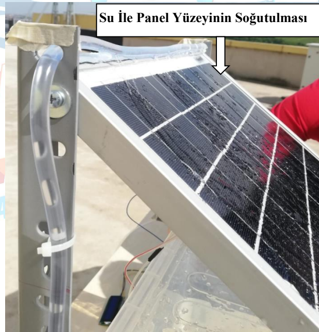
Şekil 5. Su ile panel yüzeyinin soğutulması
