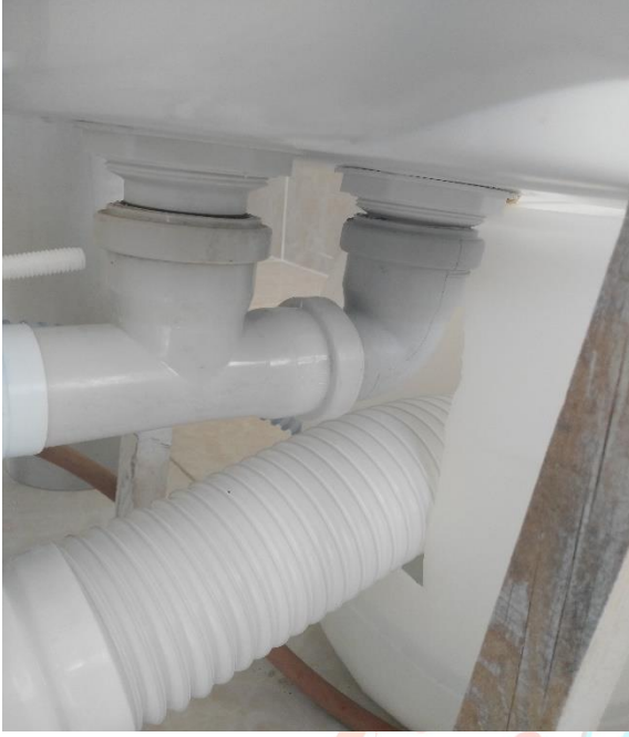
Resim 4. Atık ve temiz su rezervuarı alt bağlantısı
