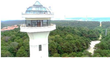
Şekil 2: Yangın Gözetleme Kulesi
