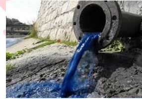
Şekil 3. Tekstil Atık suyunun kanalizasyona verilmesi
